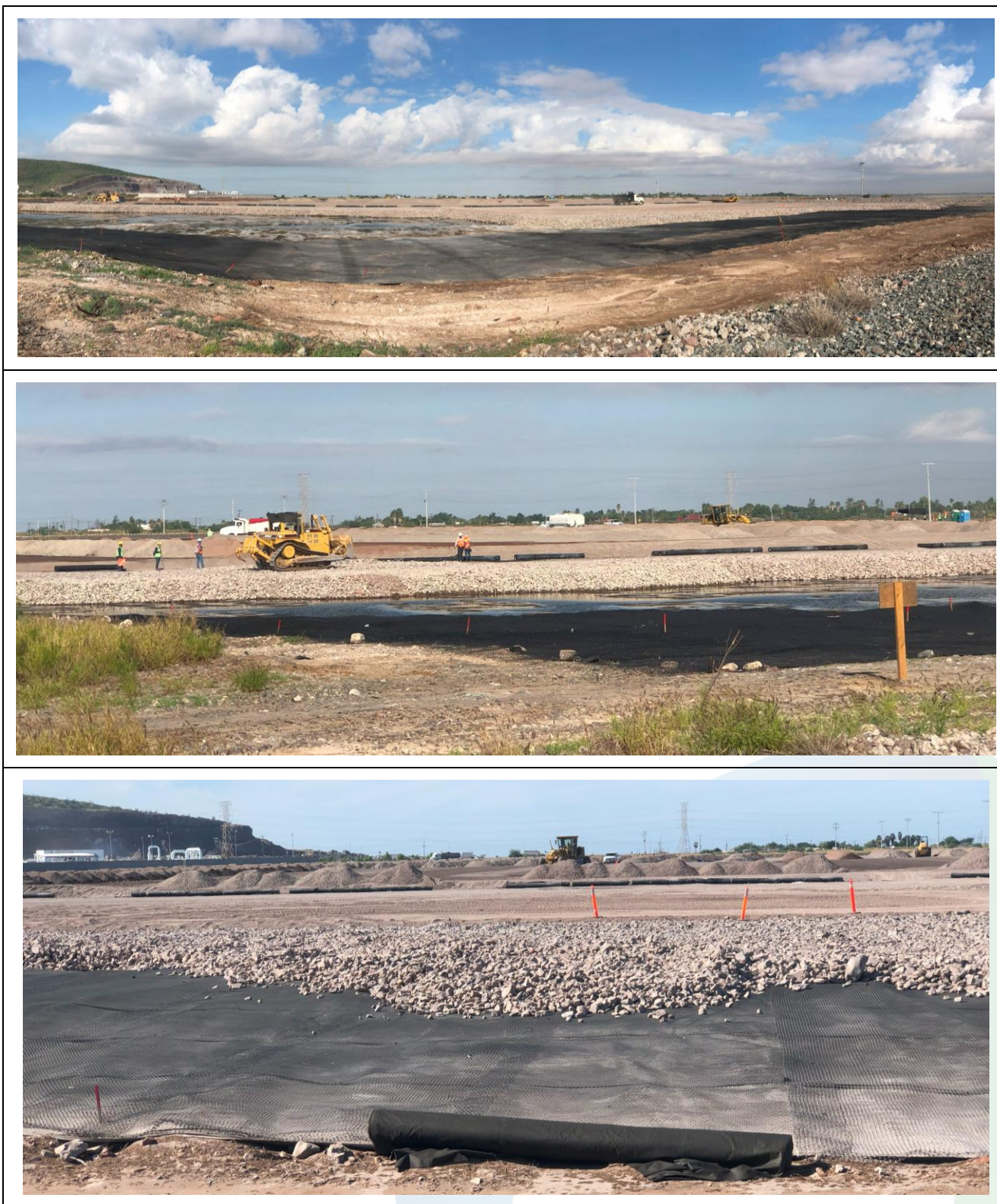
Figura 10. Relleno de la plataforma.
