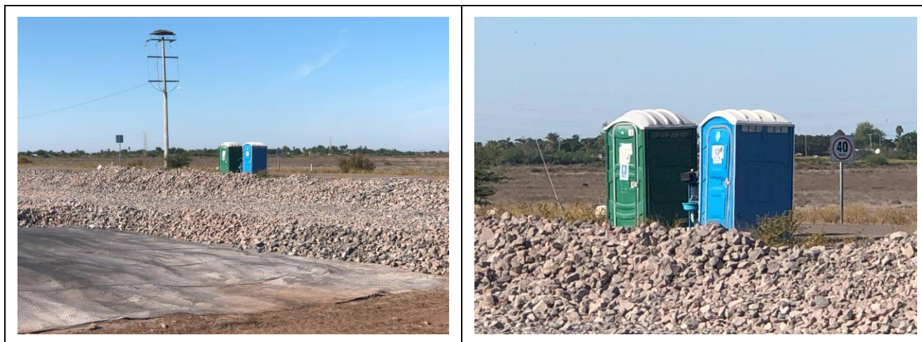
Figura 9. Instalación de sanitarios móviles.
