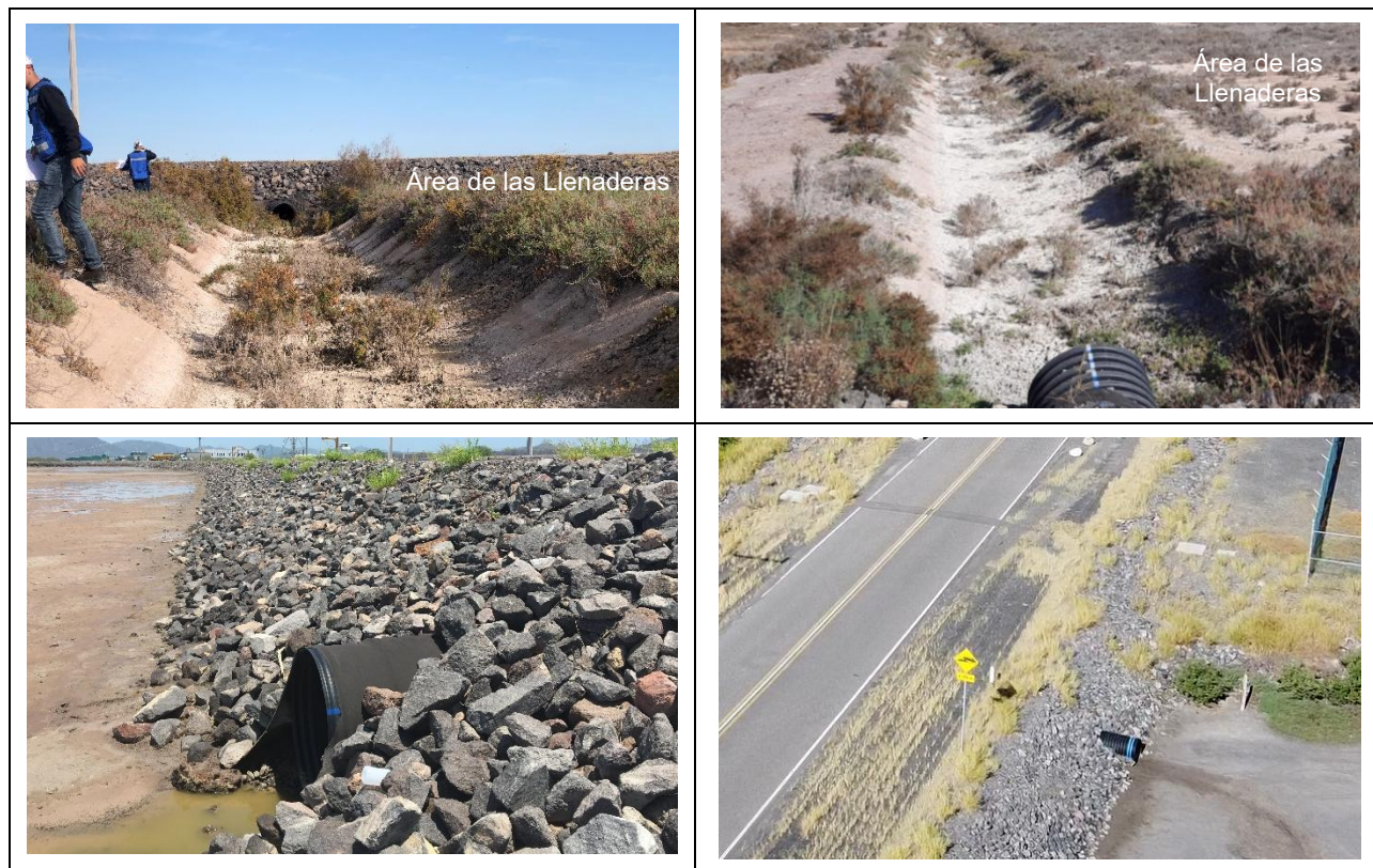
Figura 34. Mantenimiento del drenaje del camino.
