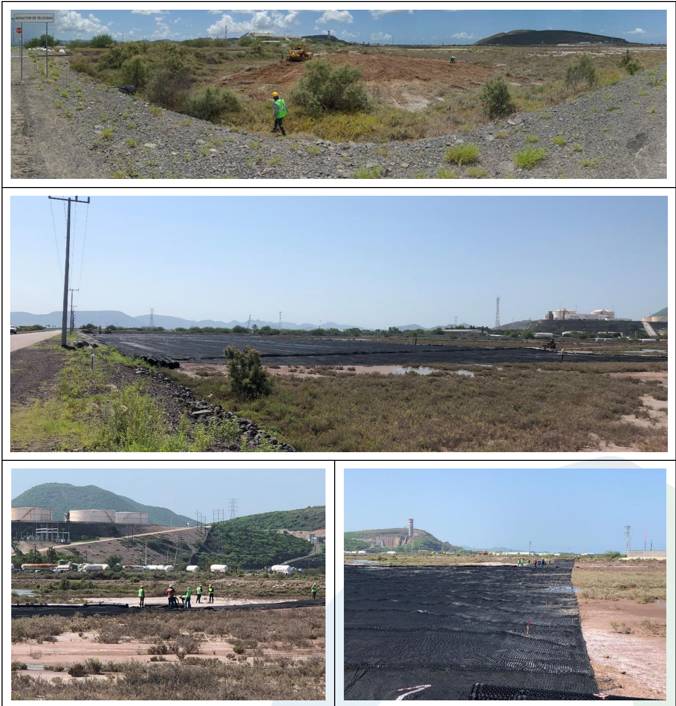
Figura 10. Relleno de la plataforma.
