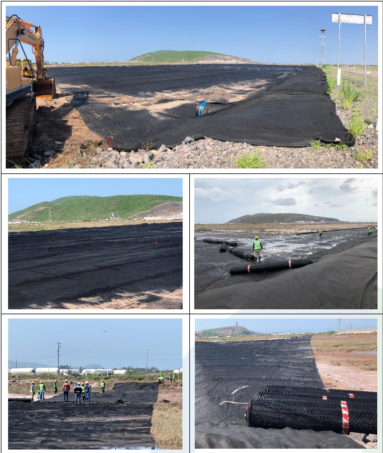
Figura 10. Relleno de la plataforma.
