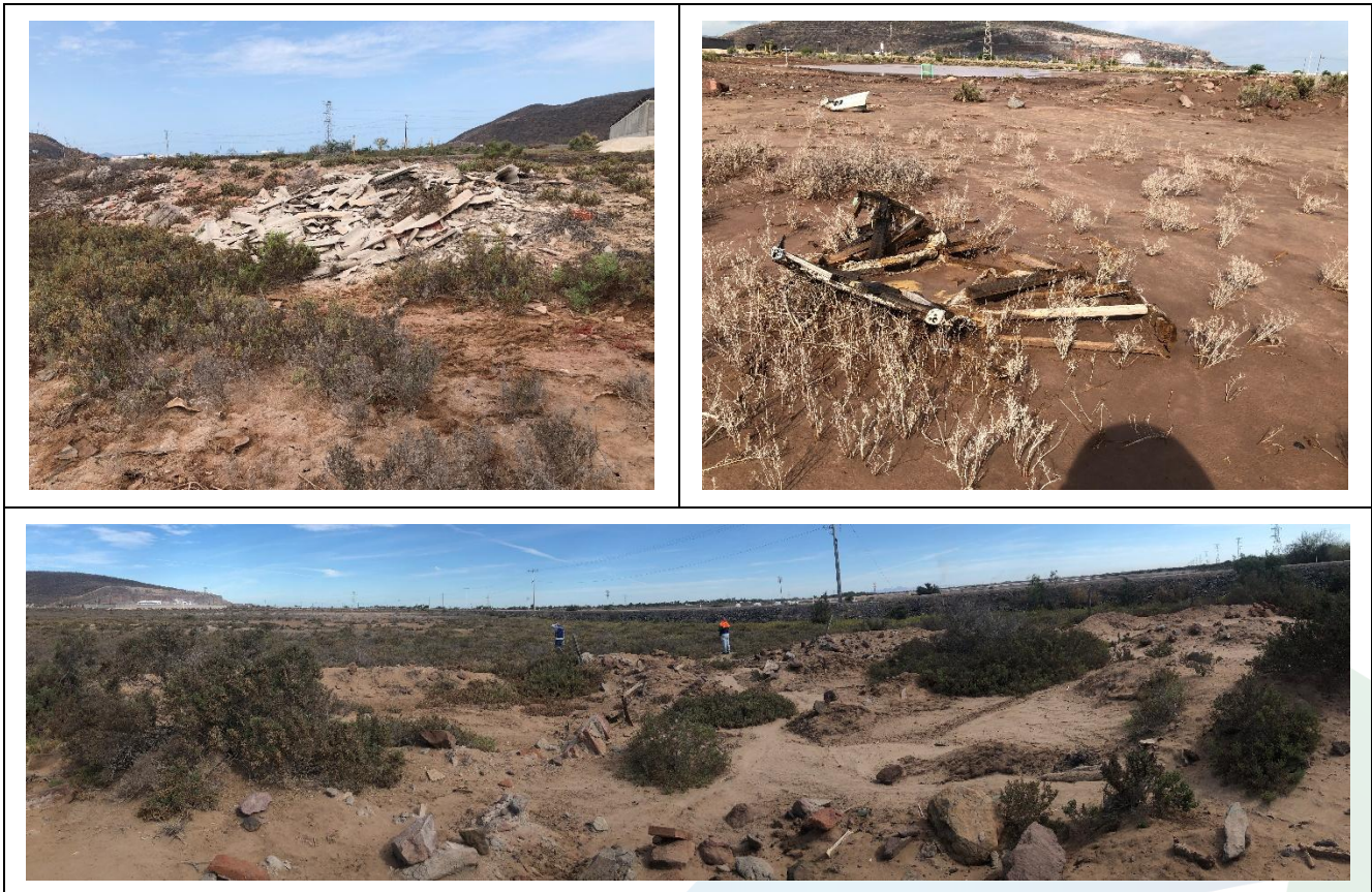
Figura 6. Limpieza del terreno.
