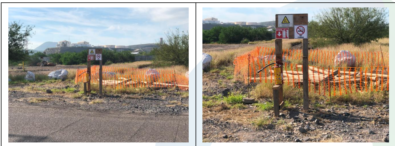
Figura 8. Almacén temporal de materiales.
