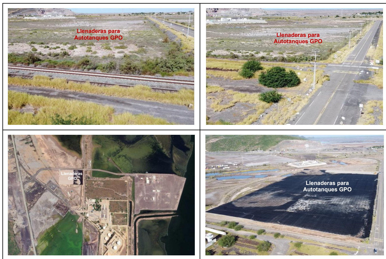
Figura 4. Condiciones del Sitio previo al inicio de obras.
