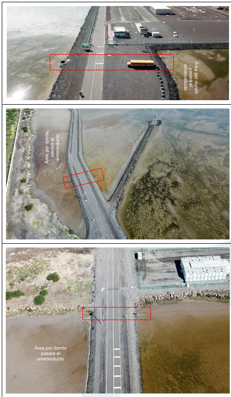
Figura 33. Mantenimiento del drenaje del camino.
