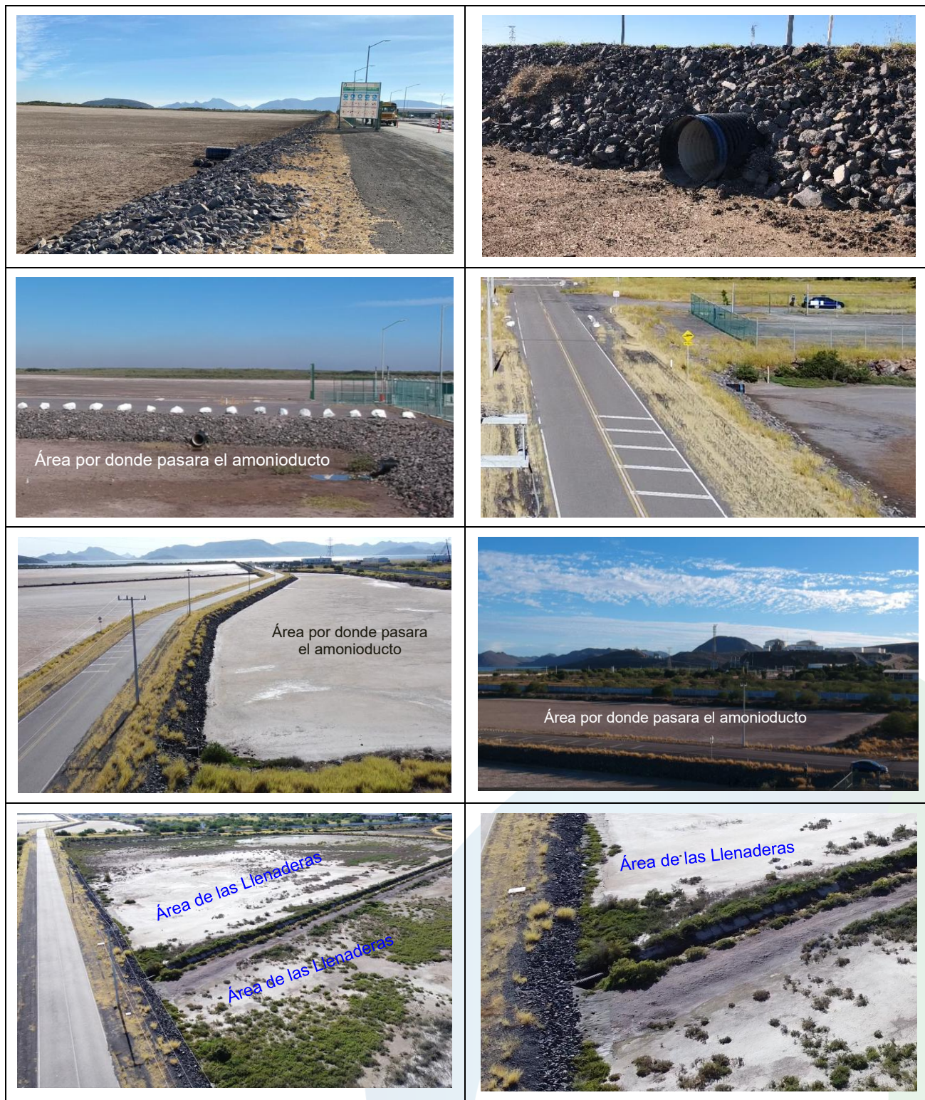
Figura 34. Mantenimiento del drenaje del camino.
