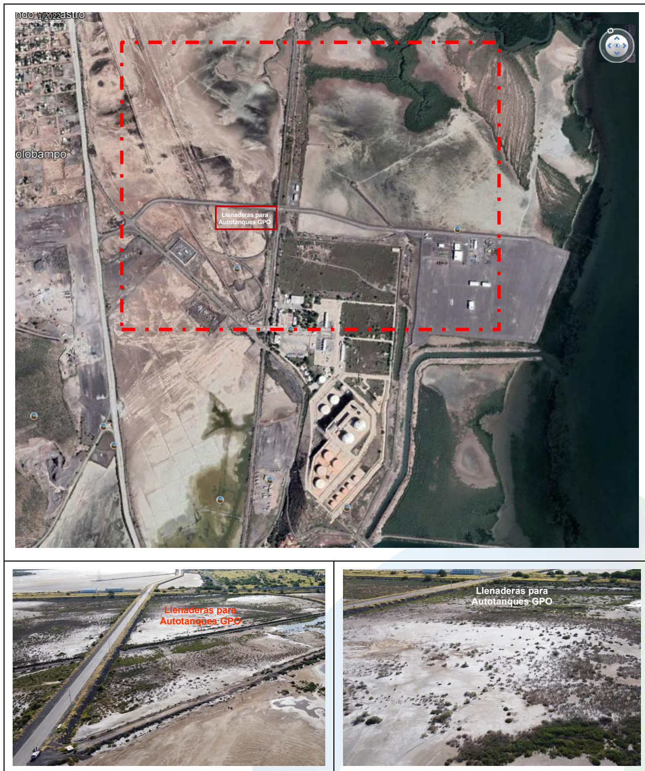
Figura 4. Condiciones del Sitio previo al inicio de obras.
