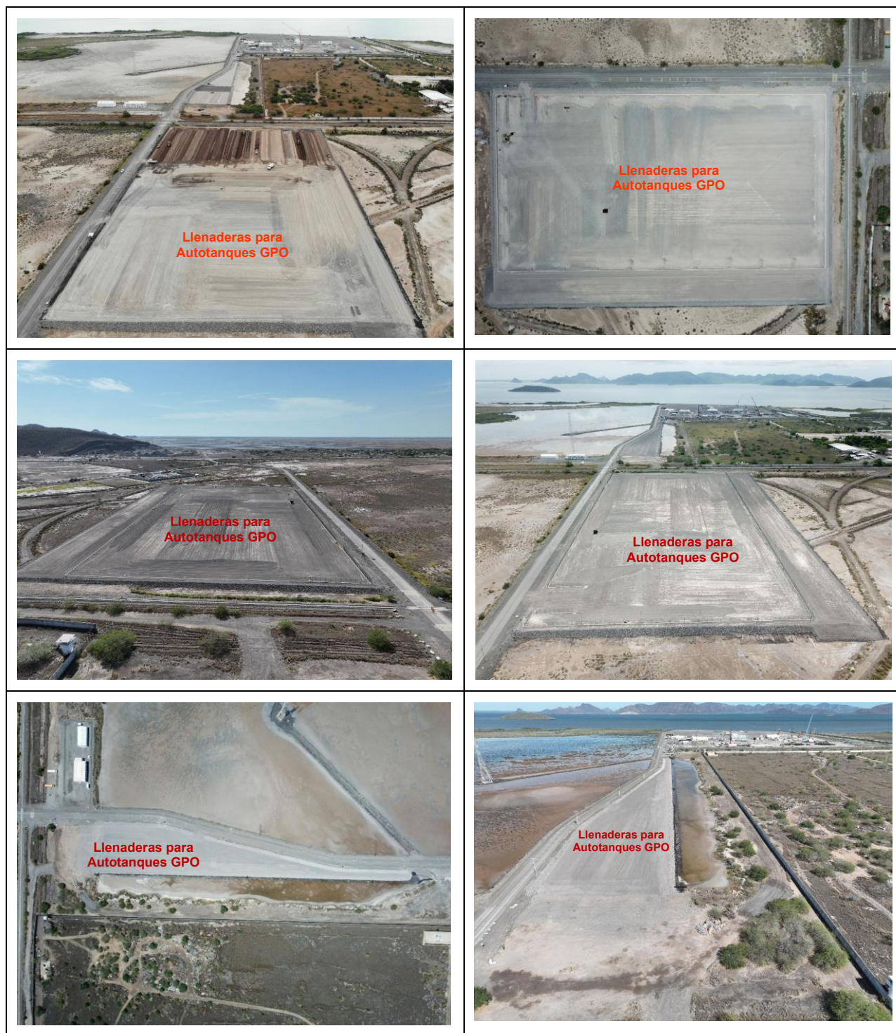
Figura 4. Condiciones del Sitio en el plazo reportado.
