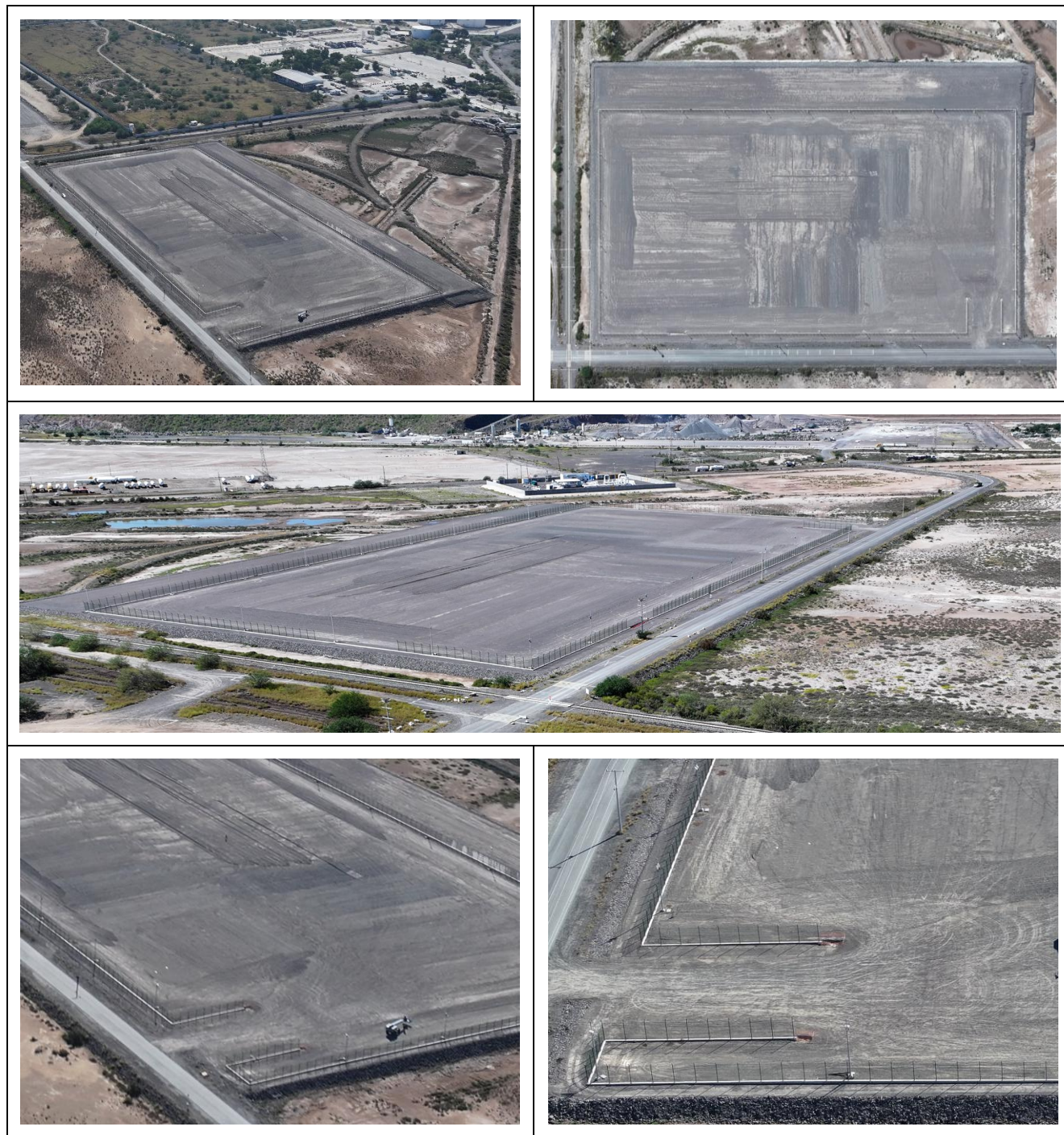
Figura 10. Relleno de la plataforma.
