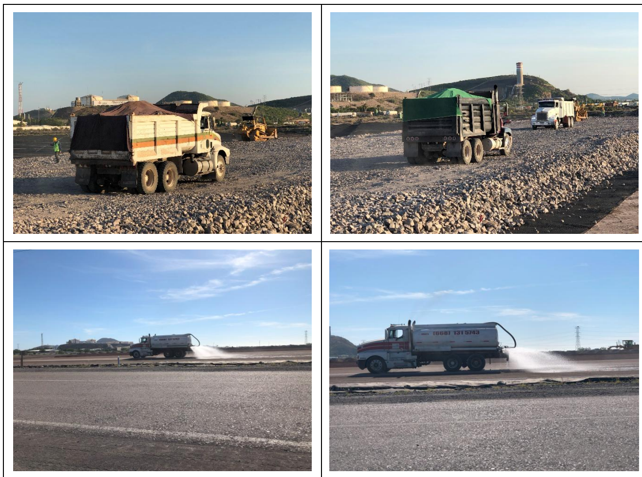
Figura 12. Uso de lonas y riegos.
