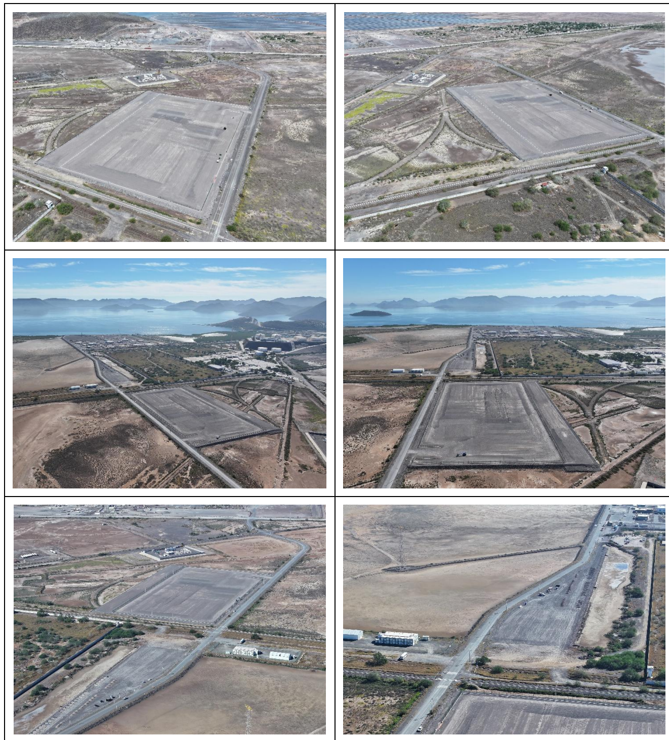
Figura 10. Relleno de la plataforma.
