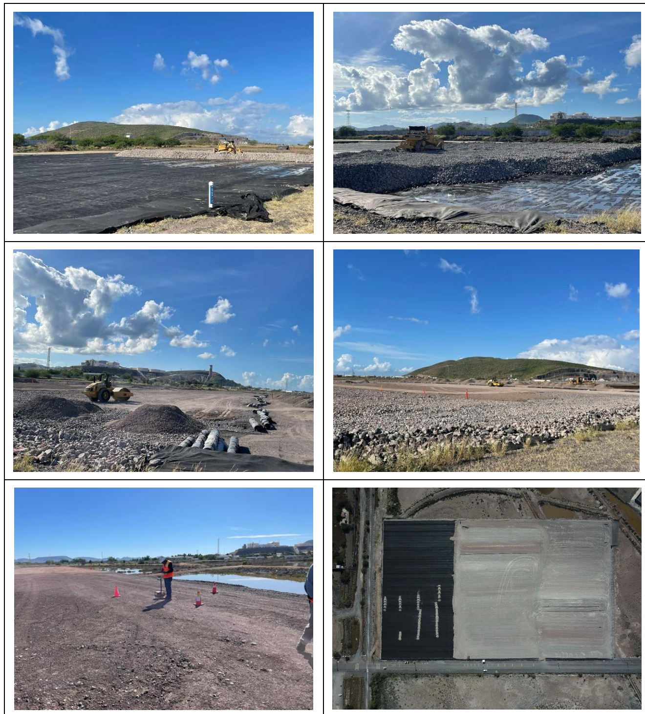
Figura 10. Relleno de la plataforma.
