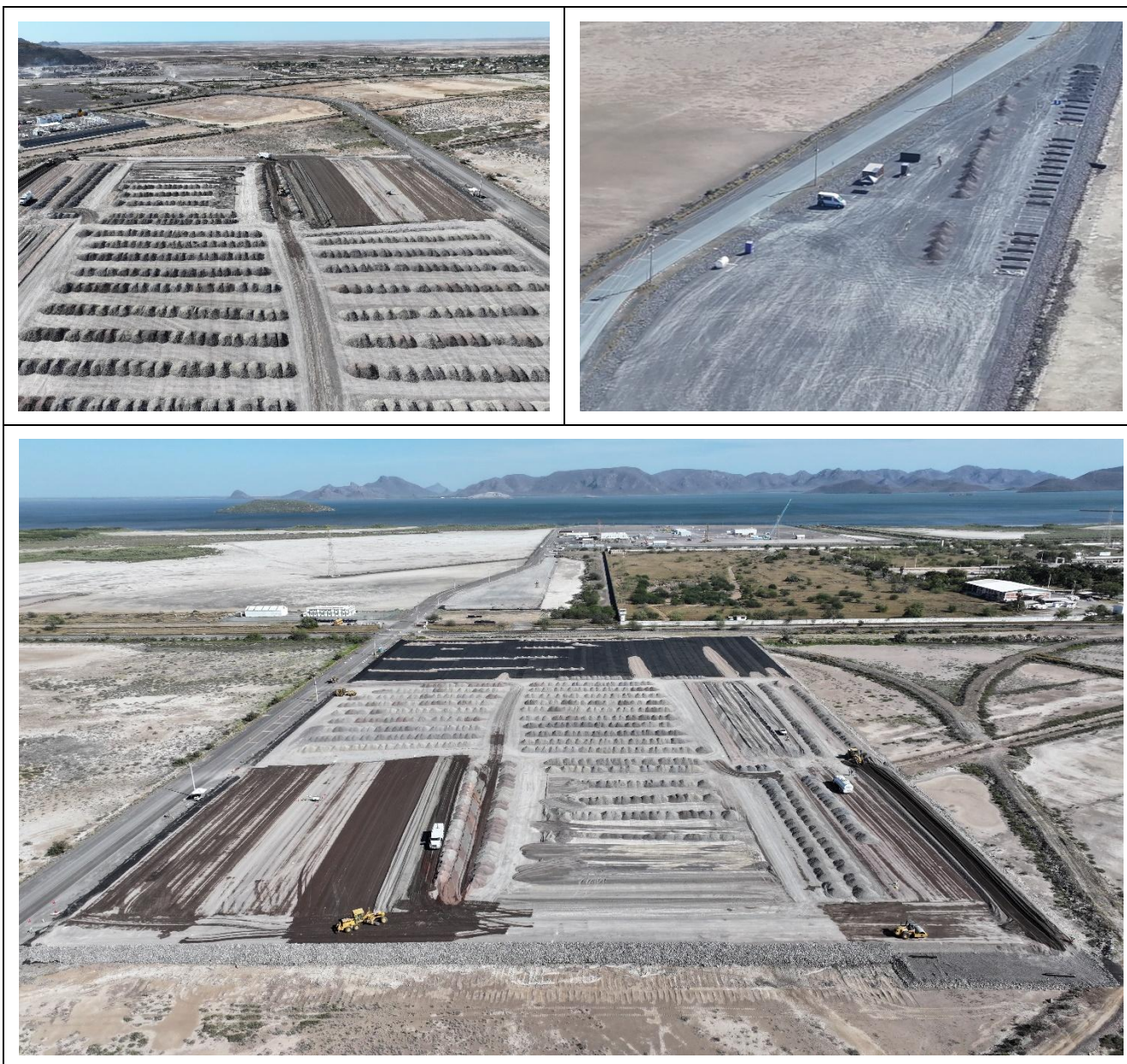
Figura 8. Almacén temporal de materiales.
