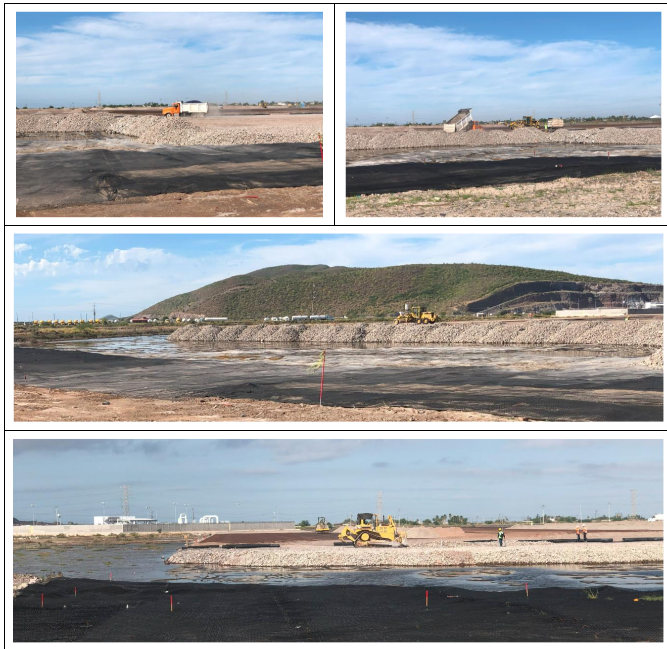
Figura 6. Nivelación del terreno.
