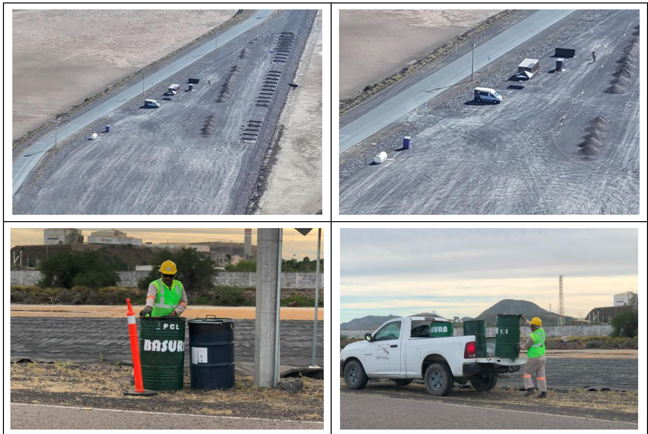
Figura 25. Acopio y traslado de residuos sólidos urbanos.
