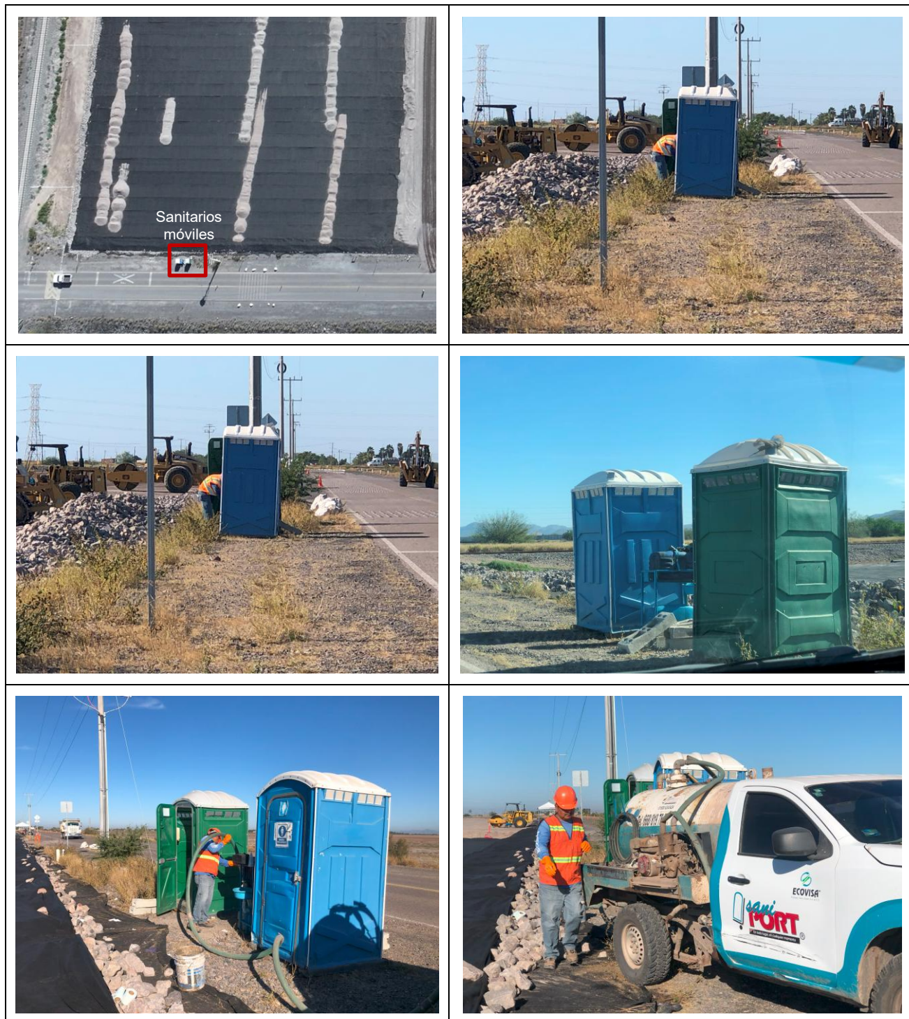
Figura 9. Instalación de sanitarios móviles.
