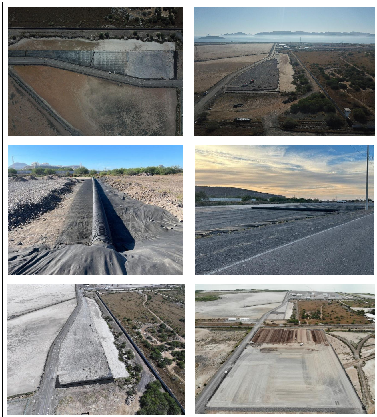
Figura 10. Relleno de la plataforma.
