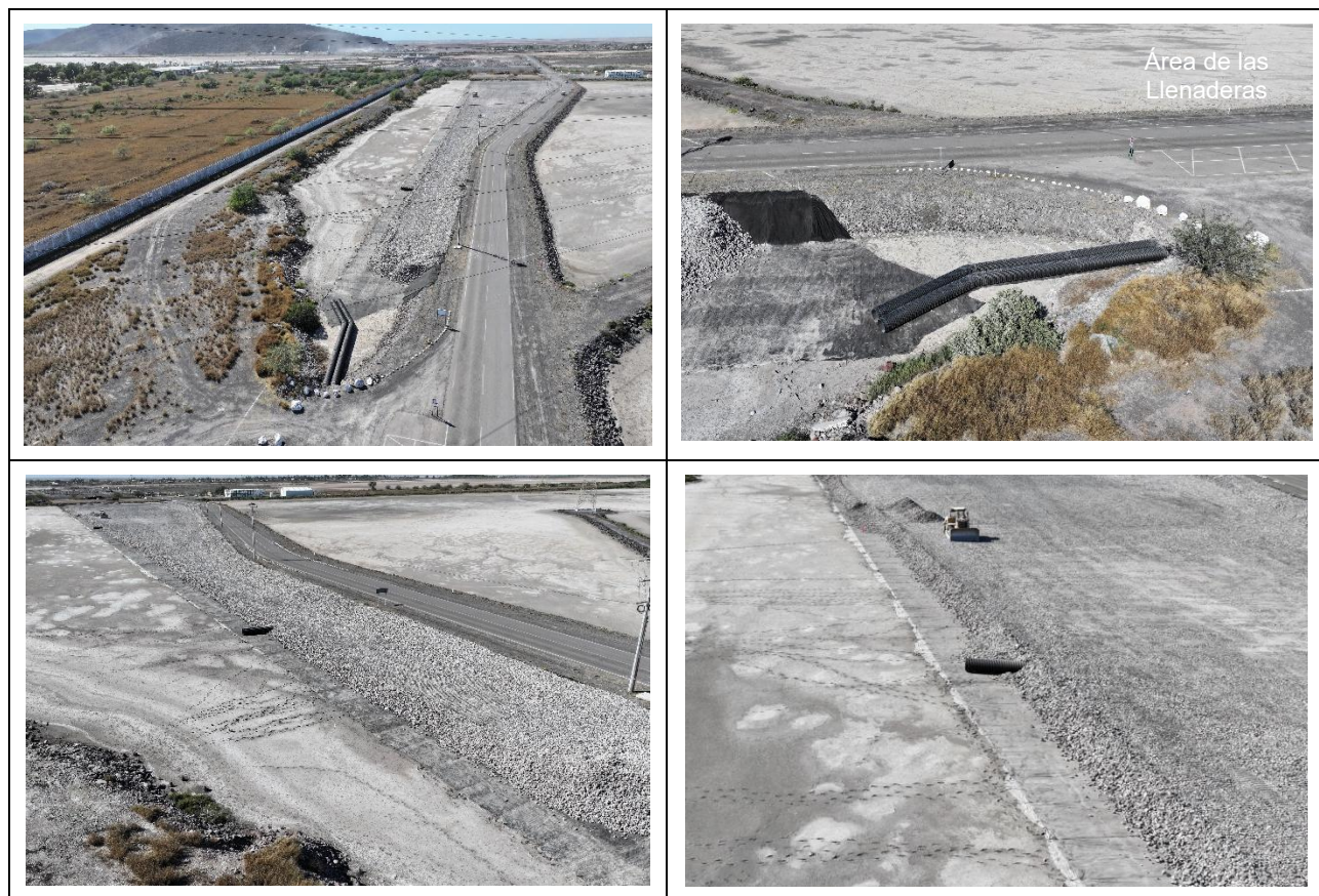
Figura 24. Mantenimiento del drenaje del camino.
