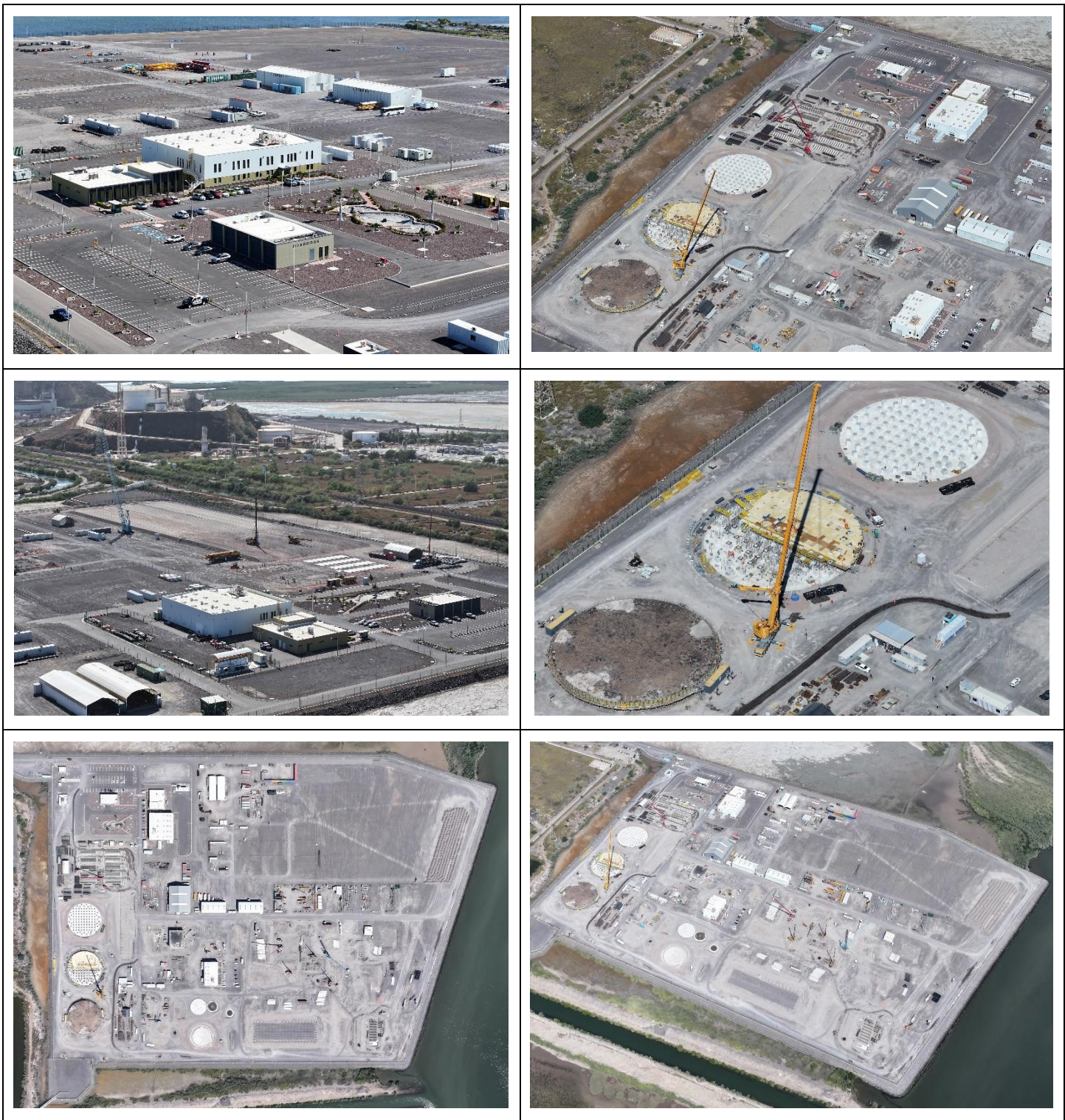
Figura 6. Aspectos de la distribución de las obras construidas del proyecto.
