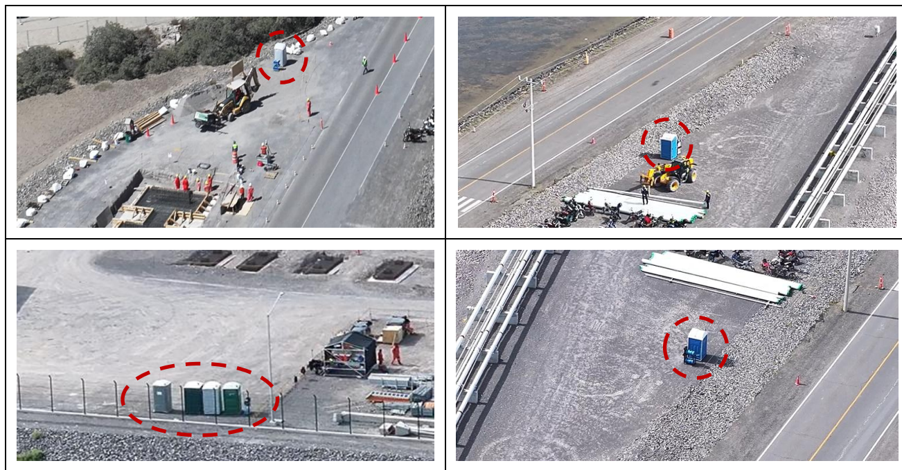
Figura 9. Instalación de sanitarios móviles.
