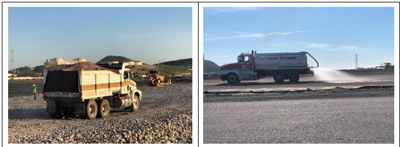
Figura 12. Uso de lonas y riegos.
