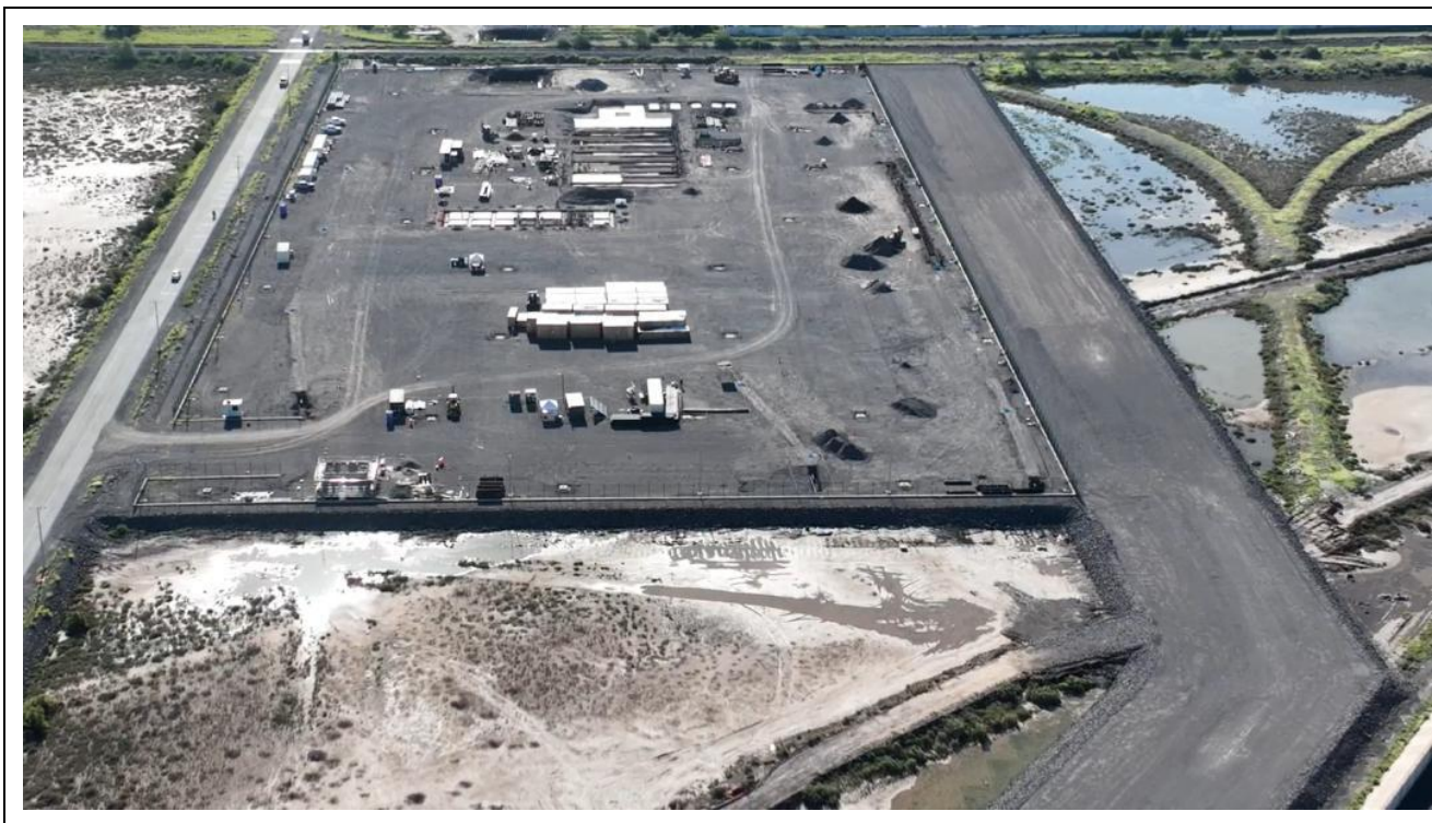
Figura 8. Obras generales en el proyecto.
