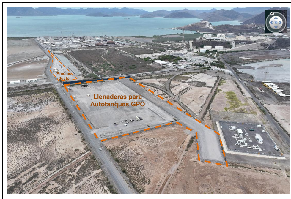
Figura 4. Condiciones del Sitio en el plazo reportado.
