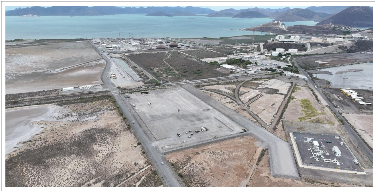
Figura 6. Nivelación del terreno.
