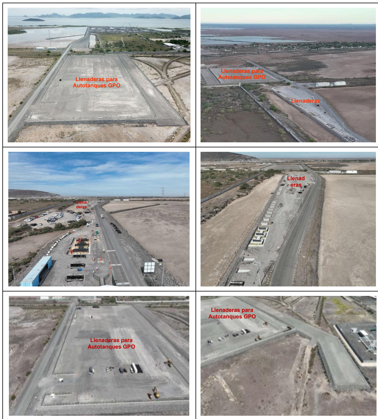
Figura 4. Condiciones del Sitio en el plazo reportado.
