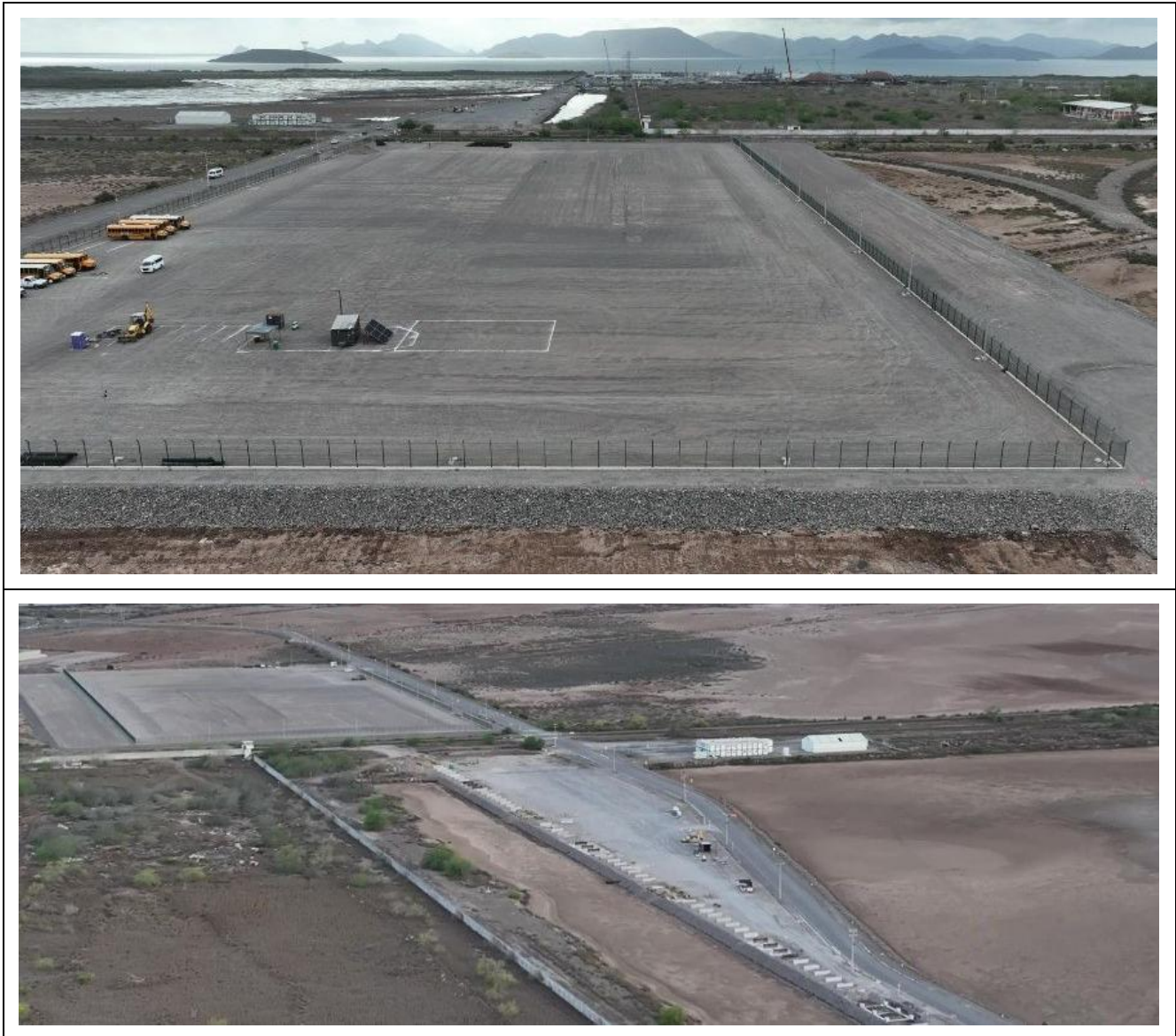
Figura 6. Nivelación del terreno.
